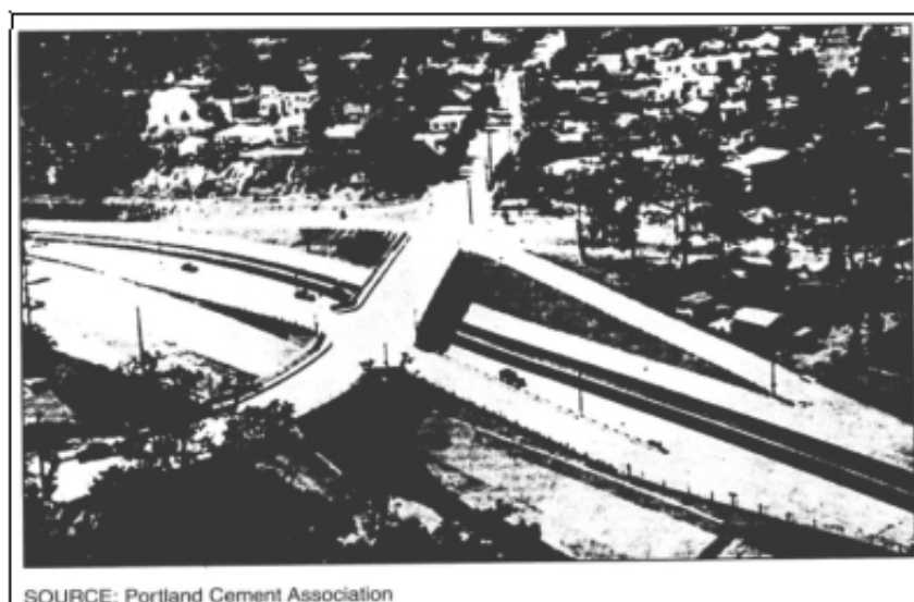
Рис. 2. Первая транспортная развязка «ромб», 1941 [2]
